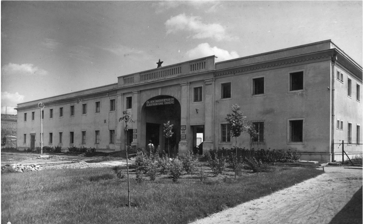
21.kép. Zalaegerszeg Aszfaltgyár bejárati épület MIEA 2412
